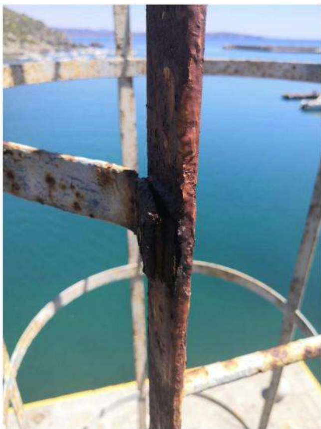
Foto n. 3 – Torri faro del porto e particolari dei fenomeni di aggressione della salsedine alle scalette di salita.
